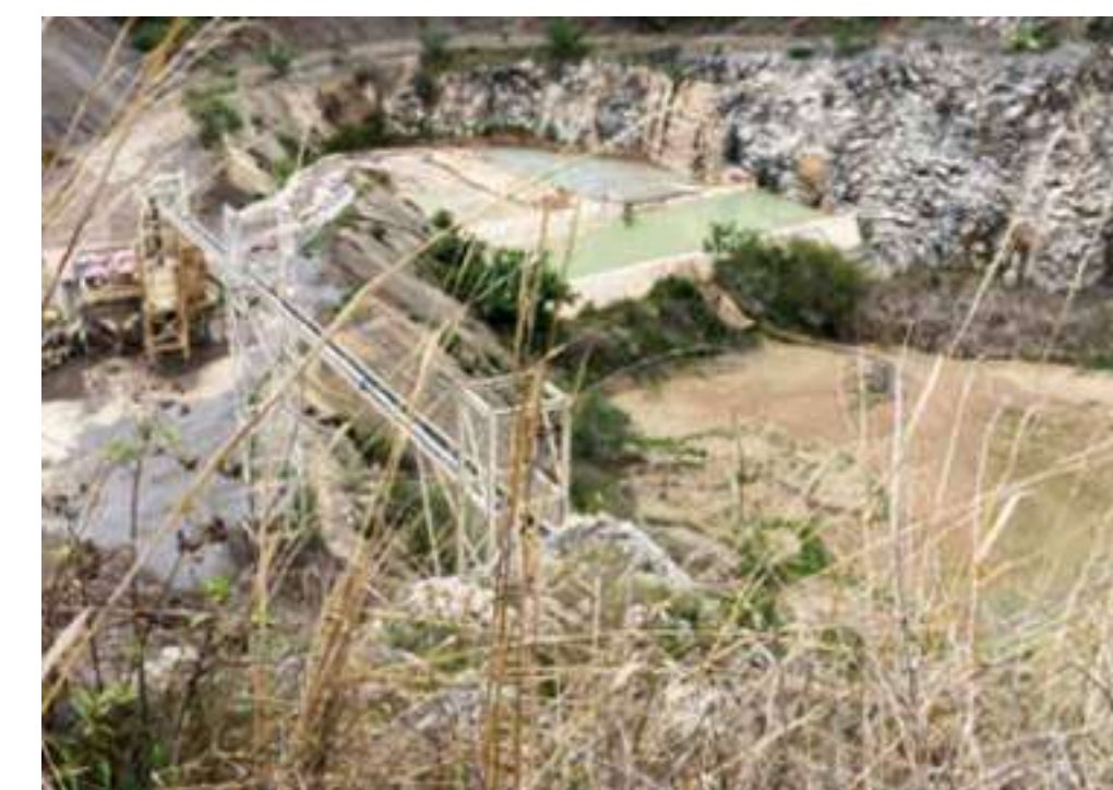
Pilas de almacenamiento de agua por captación pluvial de Planta Tecolotlán
